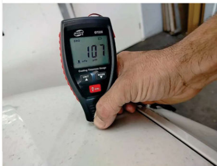
Pintura externa - dentro do padrão do fabricante
