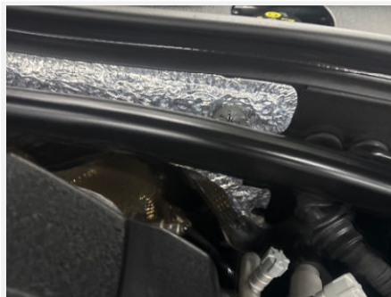
PAINEL CORTA FOGO
